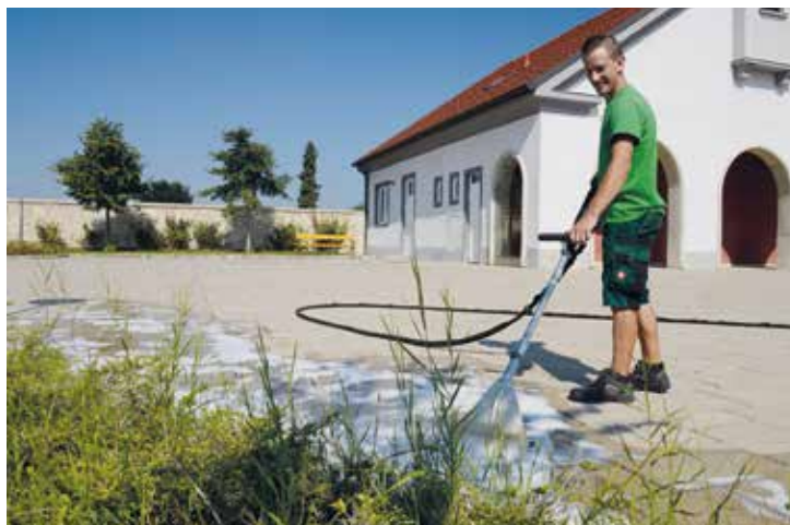
(Nass-)thermische Verfahren sind witterungsunabhängig einsetzbar und auf fast allen Flächen anwendbar.
